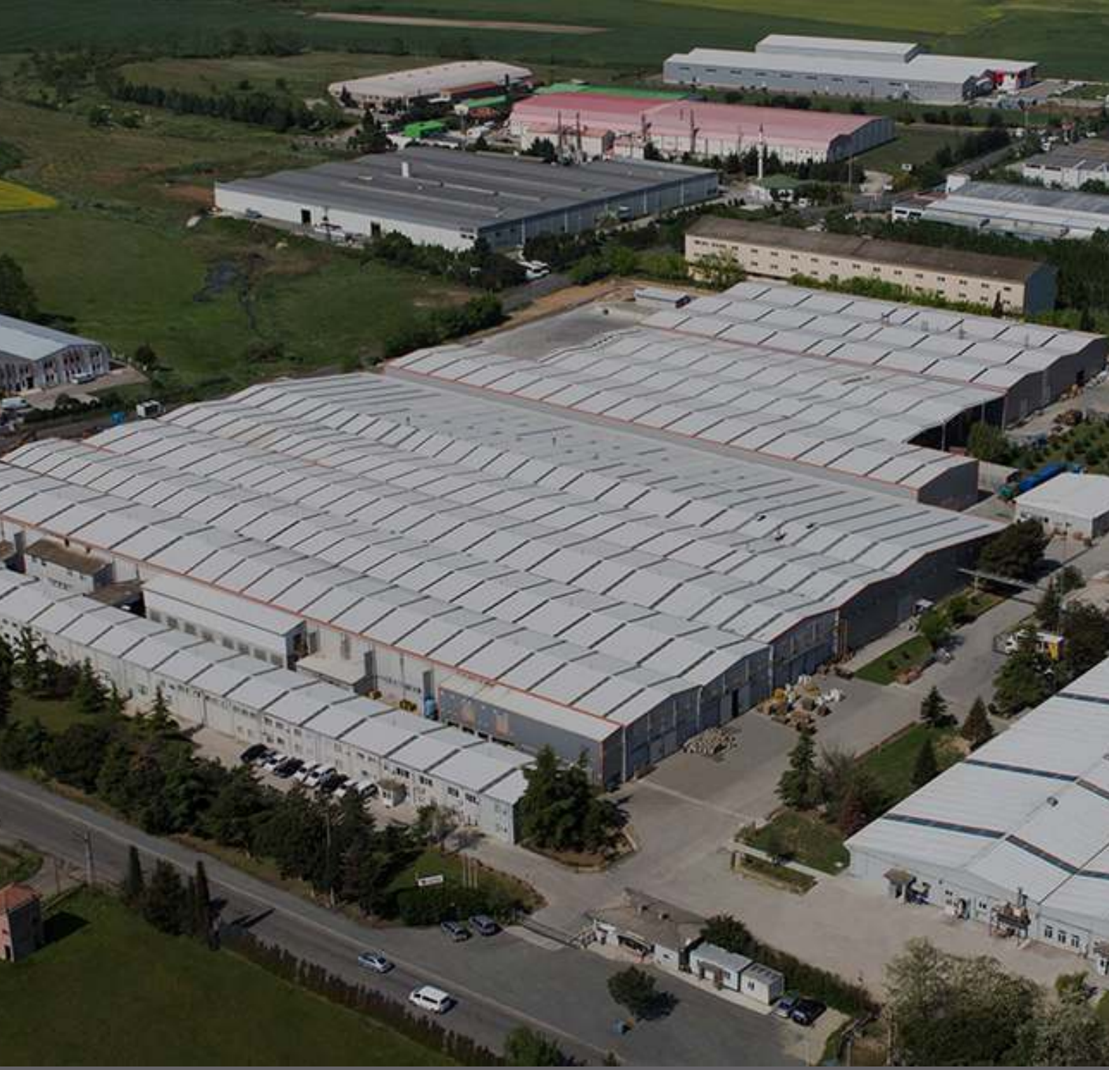
Termo Teknik Çorlu Üretim Tesisleri
